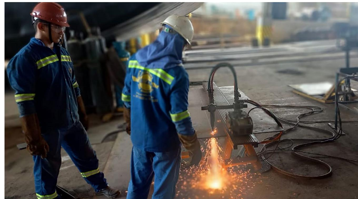
A Metalock Brasil, única empresa licenciada da SPS Technology no Brasil, realizou um trabalho de preenchimento no casco de um terminal flutuante, em Itacoatiara (Amazonas), reforçando a placa de aço existente e garantindo uma superfície forte e plana.
